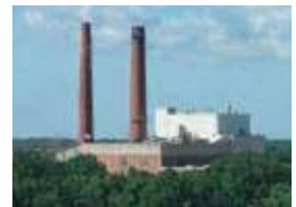
FIGURA 21.18 Planta que quema carbón en la Universidad Estatal de Michigan e incorpora un precipitador electrostático para eliminar partículas de sus emisiones.
